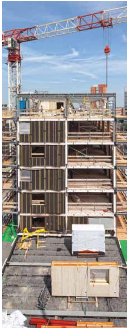
Met speciale hijsjukken wordt de staalconstructie per laag ingehesen en met de vloeren gemonteerd.
