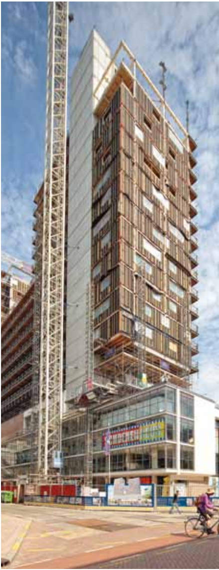
Oostingh Staalbouw bepaalde de hoofdplanning op basis van twee bouwkransen.
