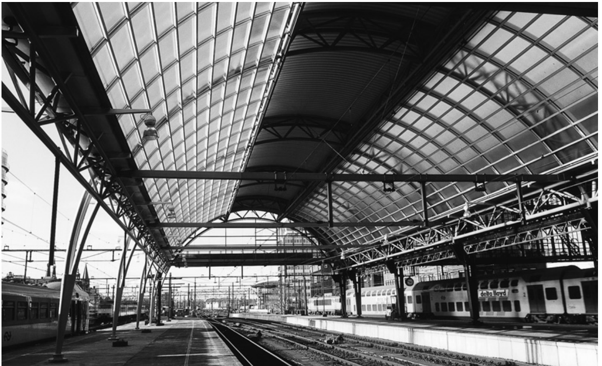
Tussenkap Amsterdam CS: een voorbeeld van een samengestelde boog.
