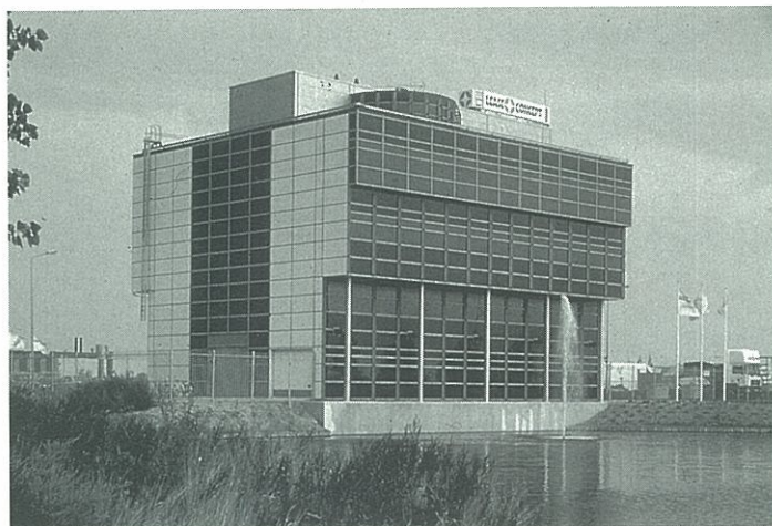
1. Kantoorgebouw Lease Concept in Amsterdam. De stalen buiskolommen zijn gevuld met gewapend beton en blijven daardoor zichtbaar.
